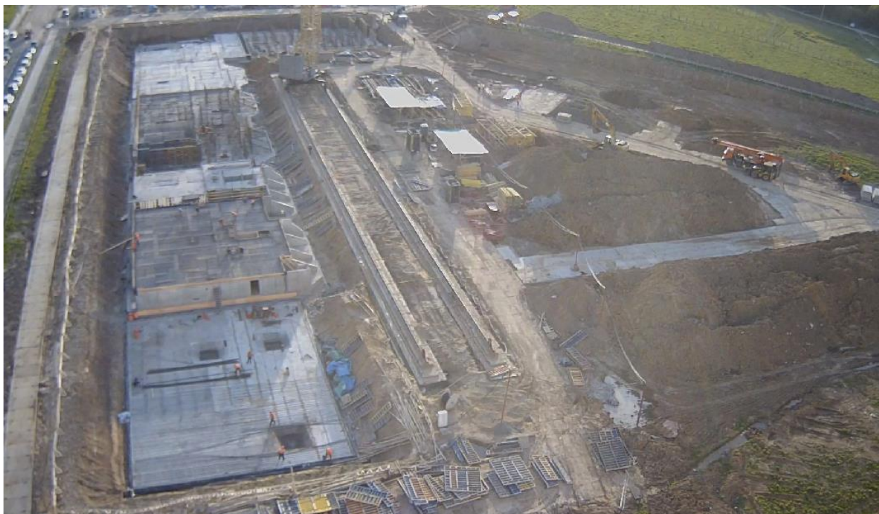
Май 2017 г. Строительство корпусов 4.1 и 4.2.:
