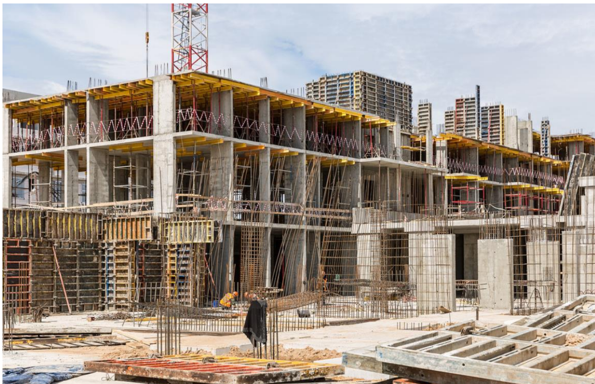
Май 2017 г. Строительство корпусов 10/1 и 10/2:
