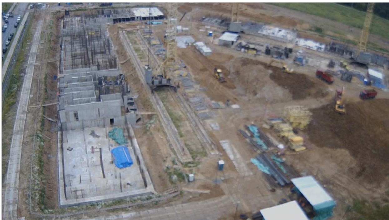
Июль 2017 г. Строительство корпусов 4/1 и 4/2:
