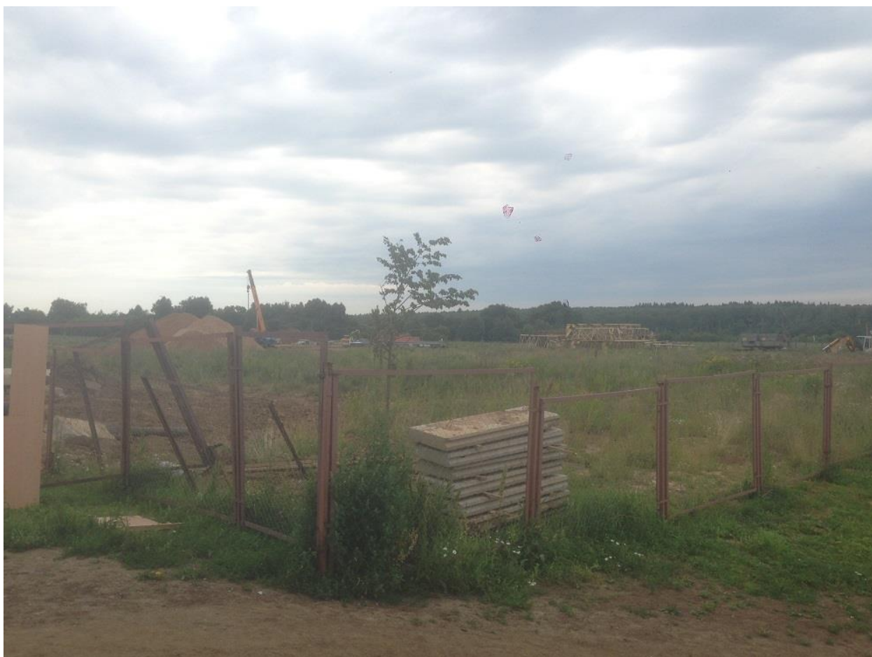
Июль 2017. Строительство корпуса 4/3:
